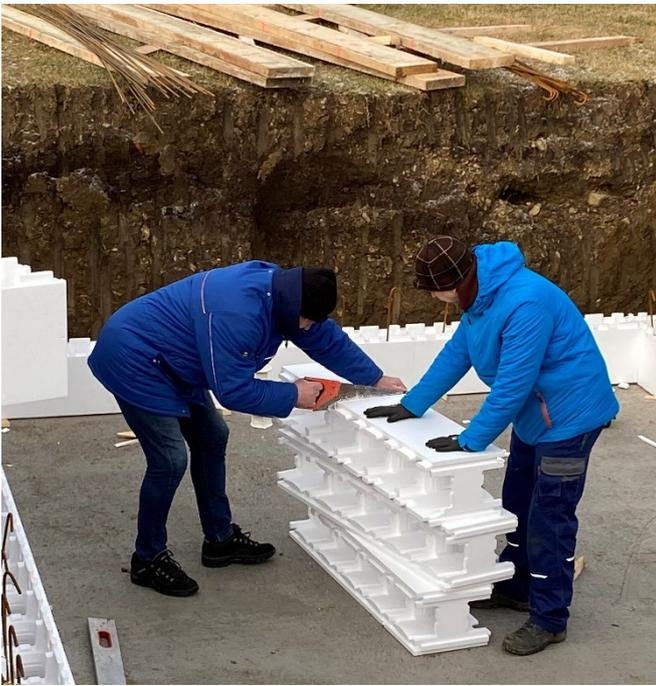
**DER OCEAN® BRICK SCHALSTEIN DARF NUR ALLE 25cm AN DEN MAKIERUNGEN ABGESCHNITTEN WERDEN!**
